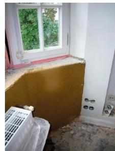
**Holzwool­dämmung und Lehmputz in einer Heizkörpernische**
