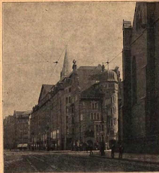
Abb. 4. Hulbehaus an der Petrikirche (Arch. Grell)
